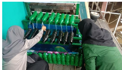
Gambar 3. Pemasangan selang instalasi untuk aliran air
